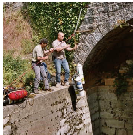
Einsatz von Hebegerät
